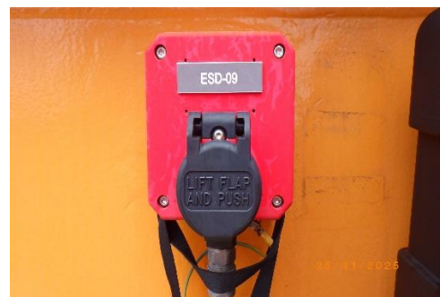
ภาพถ่ายที่ 2.2-32 Emergency Shutdown Push Button
