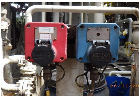
ภาพถ่ายที่ 2.2-32 Emergency Shutdown Push Button
