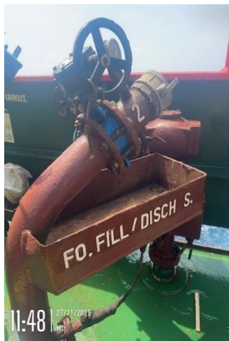
ภาพถ่ายที่ 2.2-17 ถาดรองรับด้านล่างของอุปกรณ์ และภาชนะบรรจุสารเคมี/น้ำมัน
